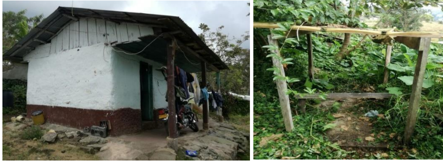
Finca Brisas Armando Castañeda centro de descanso de trabajadores y zona de mezcla.
