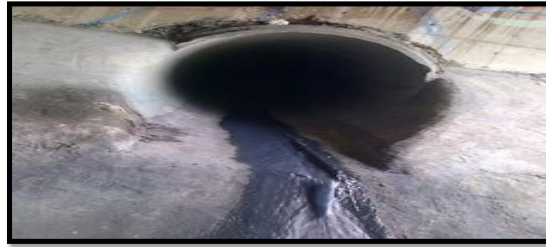
Registro fotográfico de la descarga
