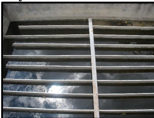
Fotografía 79 Proceso de sedimentación PTAP
