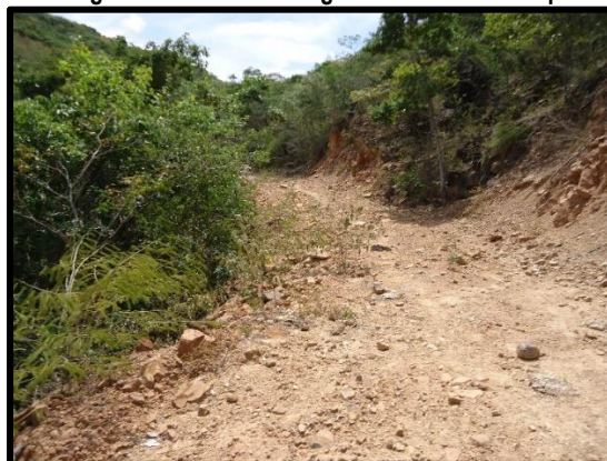
Fotografía 70 Estado de algunas vías del municipio
