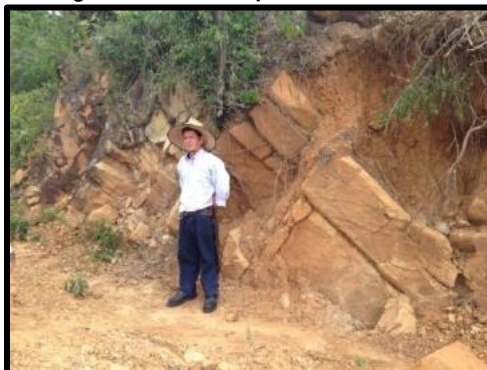
Fotografía 8 Arenitas porosas fracturadas.
