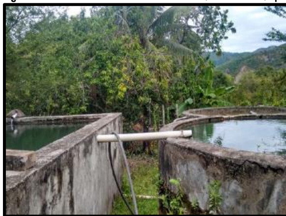
Fotografía 81 Acueducto vereda La Libertad. Quebrada la Quipileña.
