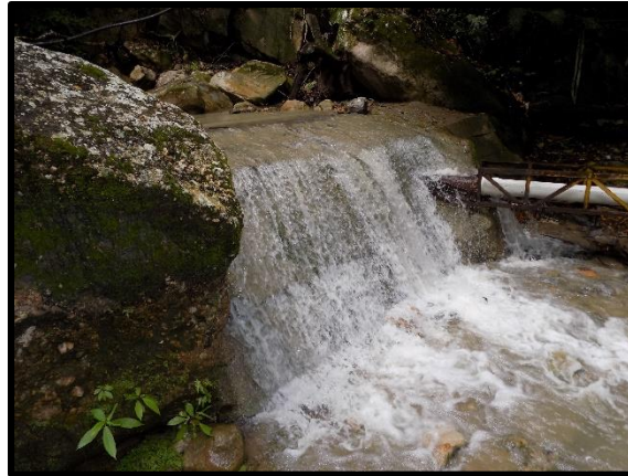
Fotografía 75 Bocatoma Quebrada El tabaco.
