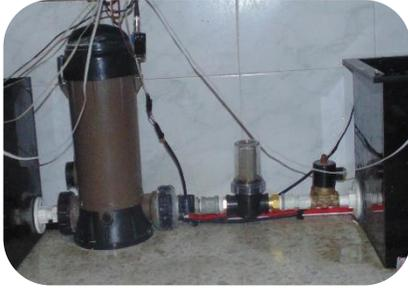
Conexion Agua Saliente del Tanque No. 2, por union en PVC de 1/2 Pulgada, a electrovalvula, seguido de filtro de residuos solidos, y siguiente el dispensador de cloro, la salida del dispensador de cloro acoplada a Tanque No. 3. (Imagen de Derecha a Izquierda)
