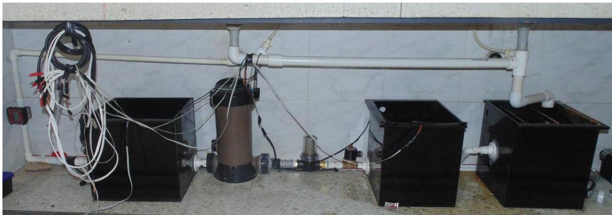
En esta imagen encontramos (derecha – izquierda), tanque trampa de grasas, tanque No. 1, tanque No. 2, evidenciando por qué se decide a hacer la modificación, la tubería de unión para cada uno de los cubículos, los elementos utilizados para el tratamiento se dejan fuera de los cubículos, ya que por espacio no pueden ir adentro de los cubículos por su tamaño, y por último la eliminación del cuarto cubículo, ya que la etapa de potencia y la fuente son situados a comodidad para la manipulación.
