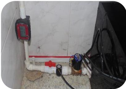
Salida del Tanque No. 3 acoplada por tubo PVC de 1/2 pulgada, a electrovalvula, seguido de Sensor de Caudal Analogico, y acoplado mediante tubo PVC de Media a Sensor de Caudal Digital.
