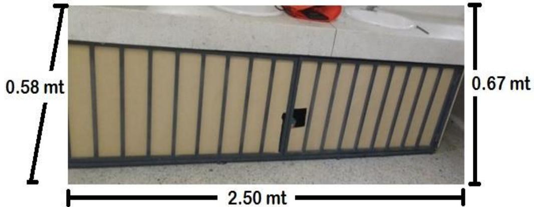
En esta imagen se evidencia el espacio que se utilizara para la instalación del prototipo, este es un espacio general que la mayoría de baños lo tienen, el baño donde se realizó la instalación del prototipo tiene las siguientes medidas: Alto 0.67 mt, Ancho 2.50 mt y Fondo 0.58 mt.
