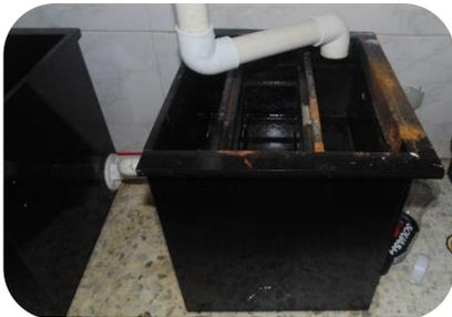
Entrada de agua al Prototipo, Tanque No. 1 Filtro de Residuos Sólidos, Trampa de Grasas.
