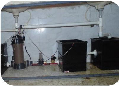
Vista Conexión en PVC de 3/4 de pulgada, salida agua lavamanos, con entrada al Prototipo.
