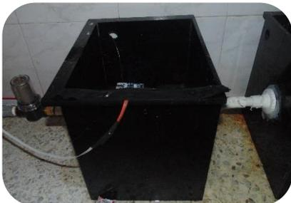
Tanque No. 2, conectado mediante Tubo PVC de 1/2 pulgada, paso de agua del Tanque No. 1 físicamente al Tanque No. 2.
