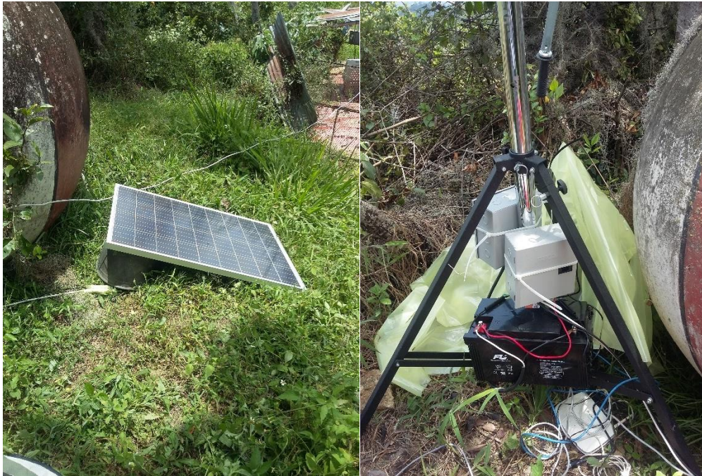
FIGURA 23 IMPLEMENTACIÓN DE SISTEMA FOTOVOLTAICO EN SAN JOSÉ
