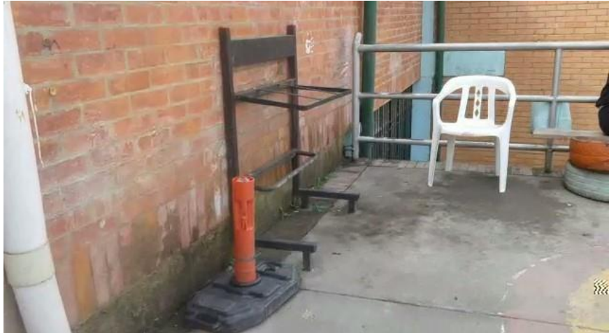
Figura 9. Deterioro de puntos ecológicos (soporte metálico sin canecas)
