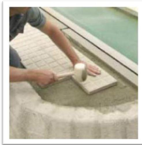
**Ilustración 40 Colocación y remate del pavimento**
