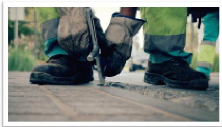
**Ilustración 43 Apertura de la plataforma del contenedor soterrado (SOTKON, Especificaciones Técnicas, 2016)**
