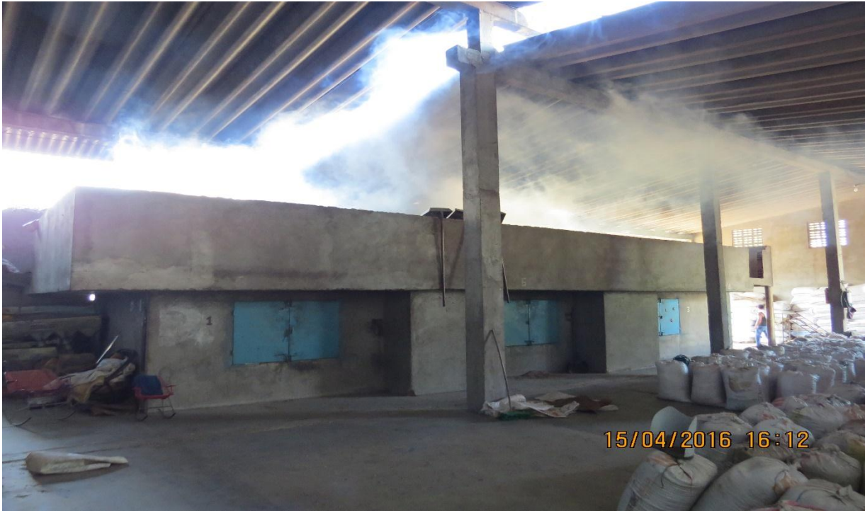
Figura 10. Silos de café en pleno funcionamiento para el secado del grano
