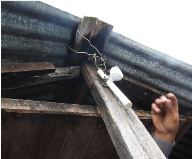
Ilustración 68 Instalación de mástil plástico en la columna de la casa.
