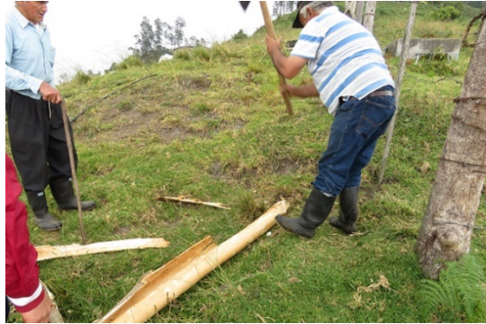
Ilustración 46 Preparación del poste.
