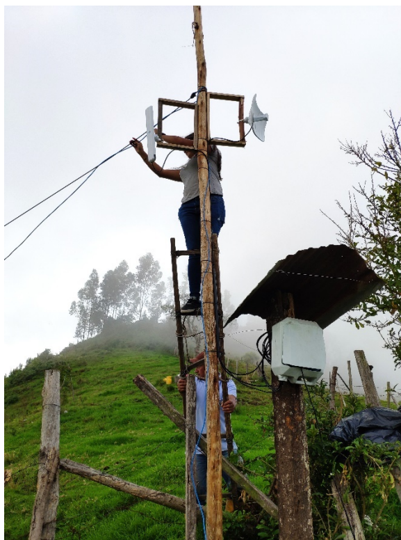
Ilustración 80 Despliegue de cable de red en el cerro.
