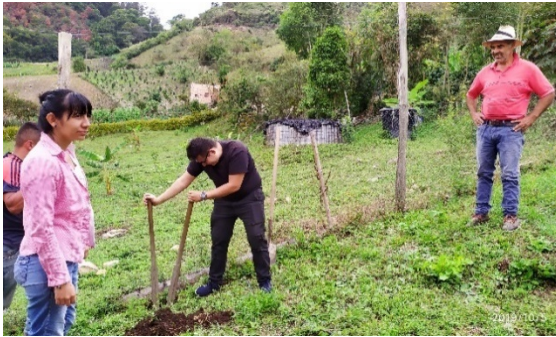
Ilustración 64 Preparación del hoyo para el poste.
