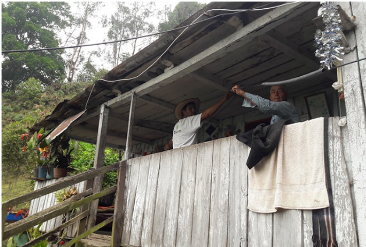
Ilustración 49 Instalación del tendido eléctrico en la casa.
