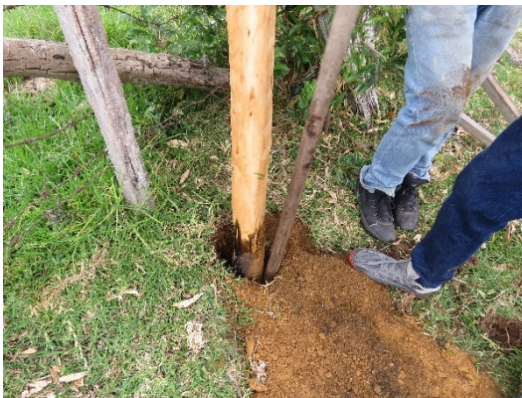
Ilustración 47 Inmunizada de la base del poste.
