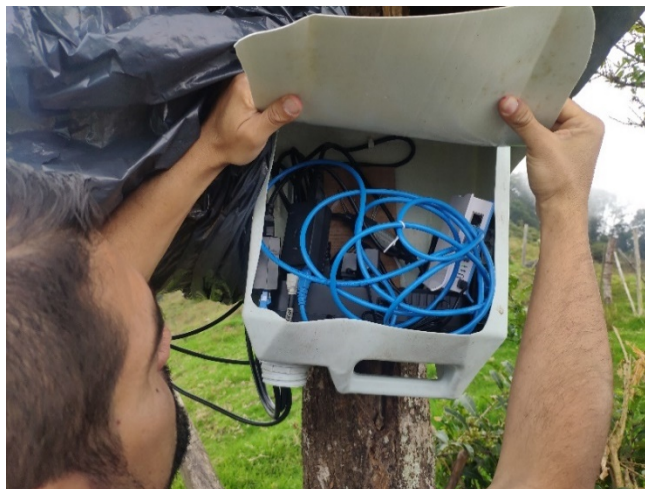
Ilustración 54 Caja de inspección instalada.
