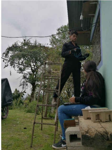
Ilustración 59 Instalación de cables.
