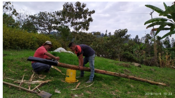
Ilustración 63 Inmunizada de la base del poste.
