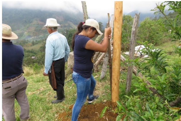
Ilustración 48 Instalación del poste.
