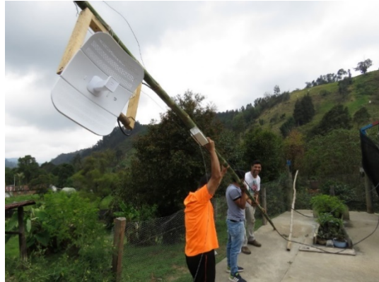
Ilustración 77 Despliegue de la torre.
