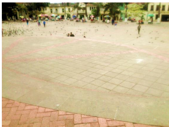
Foto 17 caída escaleras - parque central tomada por Edwin ruiz
