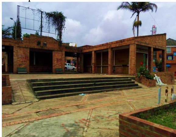
Foto 25 edificación abandonada – poblito tomada por Edwin Ruiz
