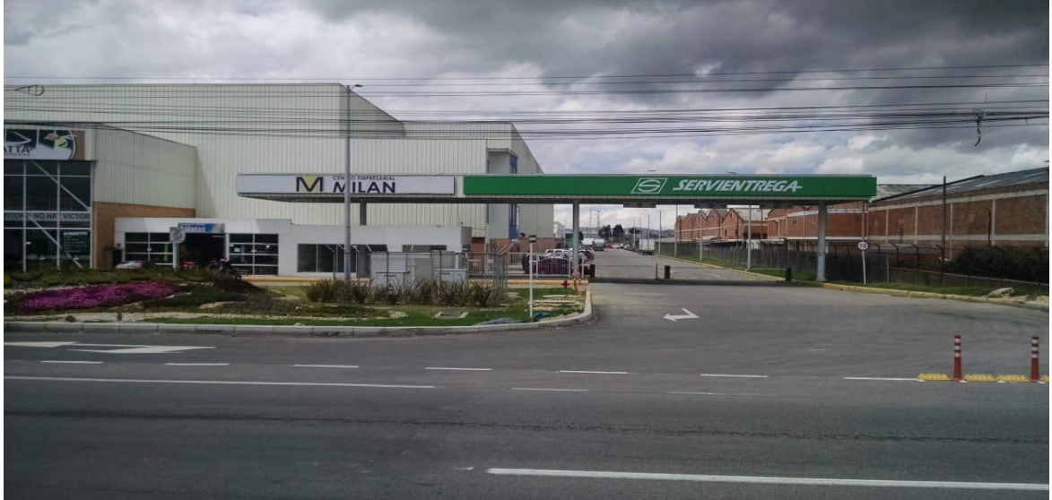
Figura 2 Nave regional Cota
