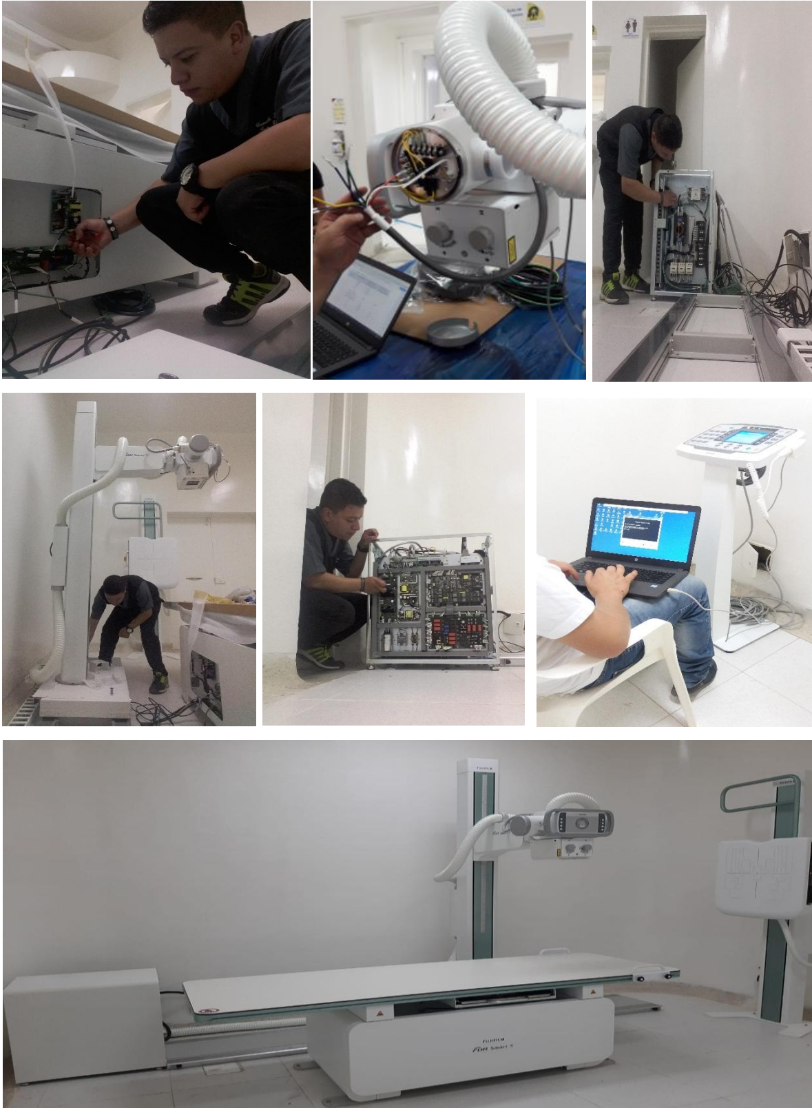
Figura 23. Instalación Equipo de rayos X convencional parte 3 (Autor)
