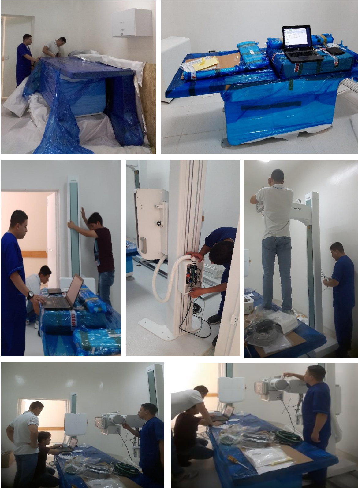
Figura 22. Instalación Equipo de rayos X convencional parte 2 (Autor)
