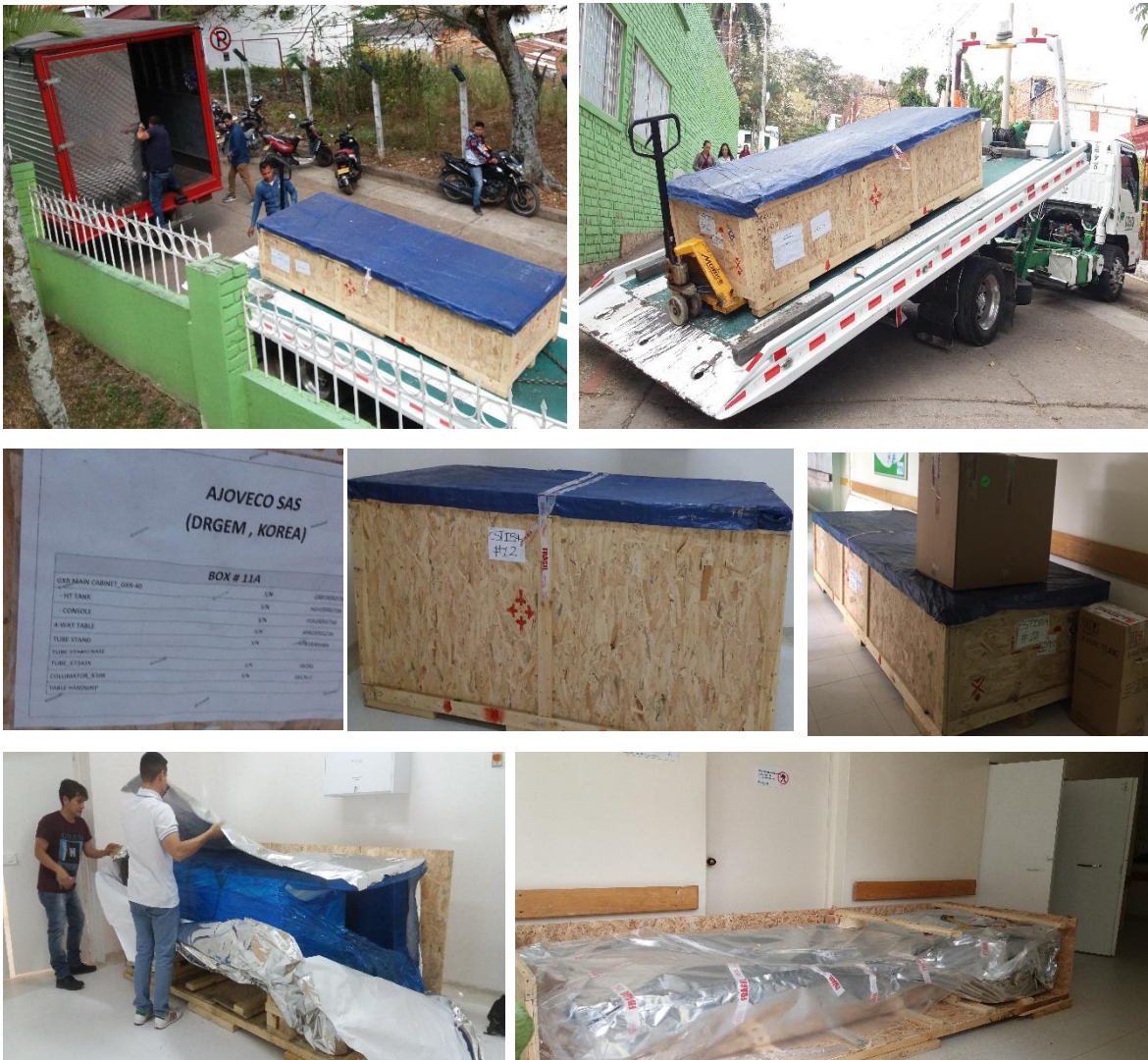
Figura 21. Instalación Equipo de rayos X convencional parte 1 (Autor)
