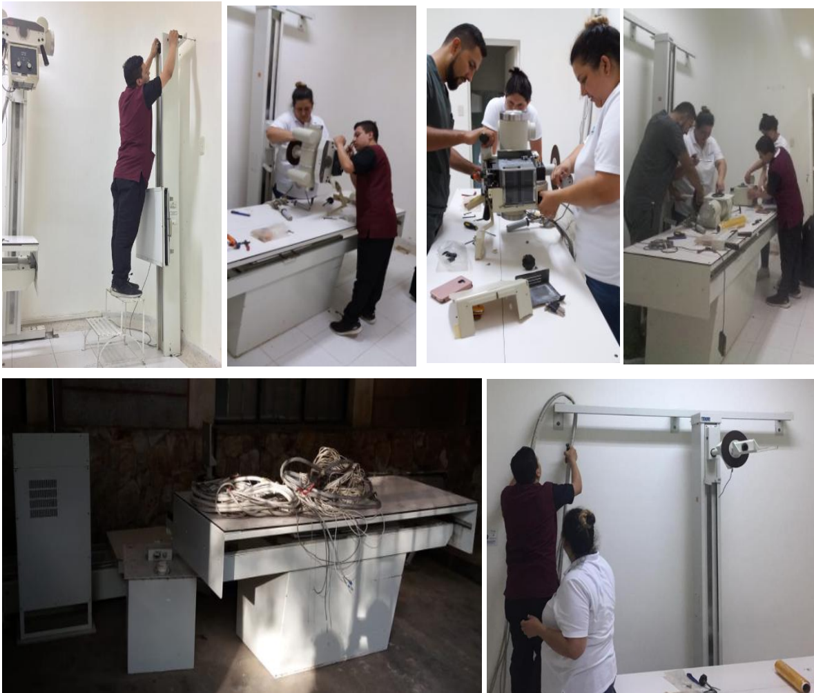
Figura 20. Desinstalación Equipo de rayos X convencional (Autor)
