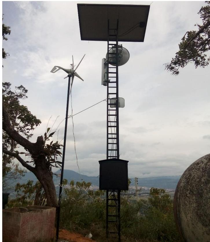
*Figura 46. Instalación estructura de soporte del sistema eólico*
