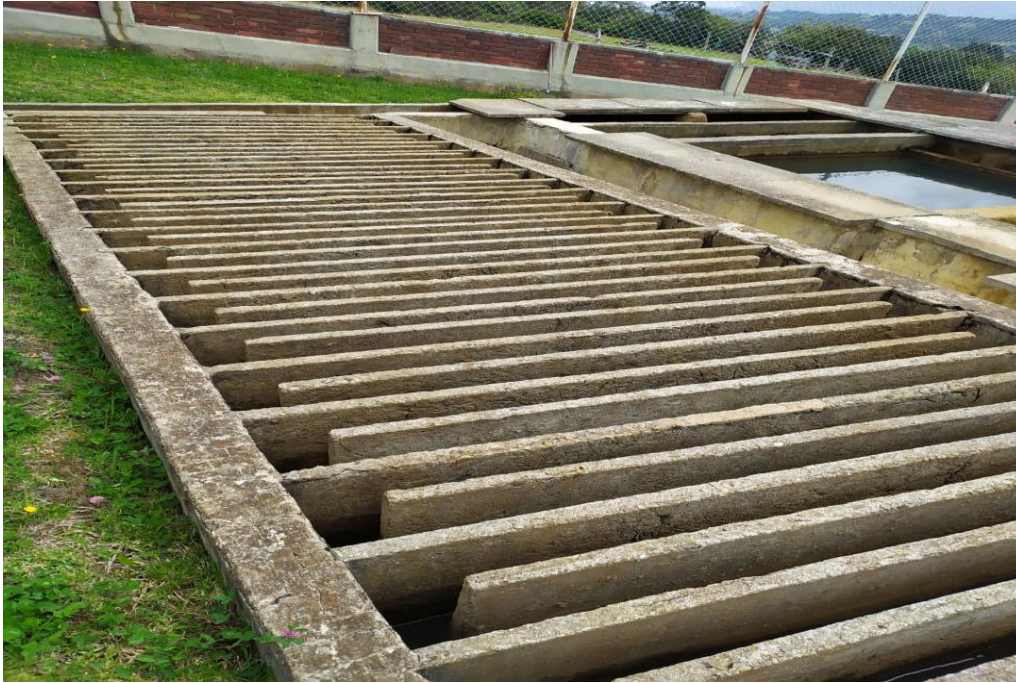
Ilustración 6: Floculador de flujo horizontal.
