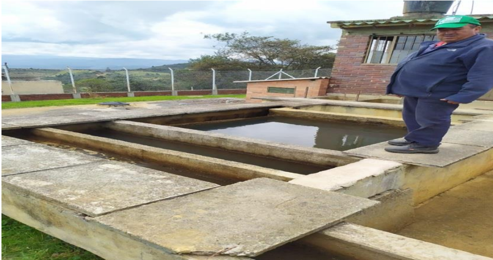
Ilustración 7: Láminas de asbesto y sedimentador
