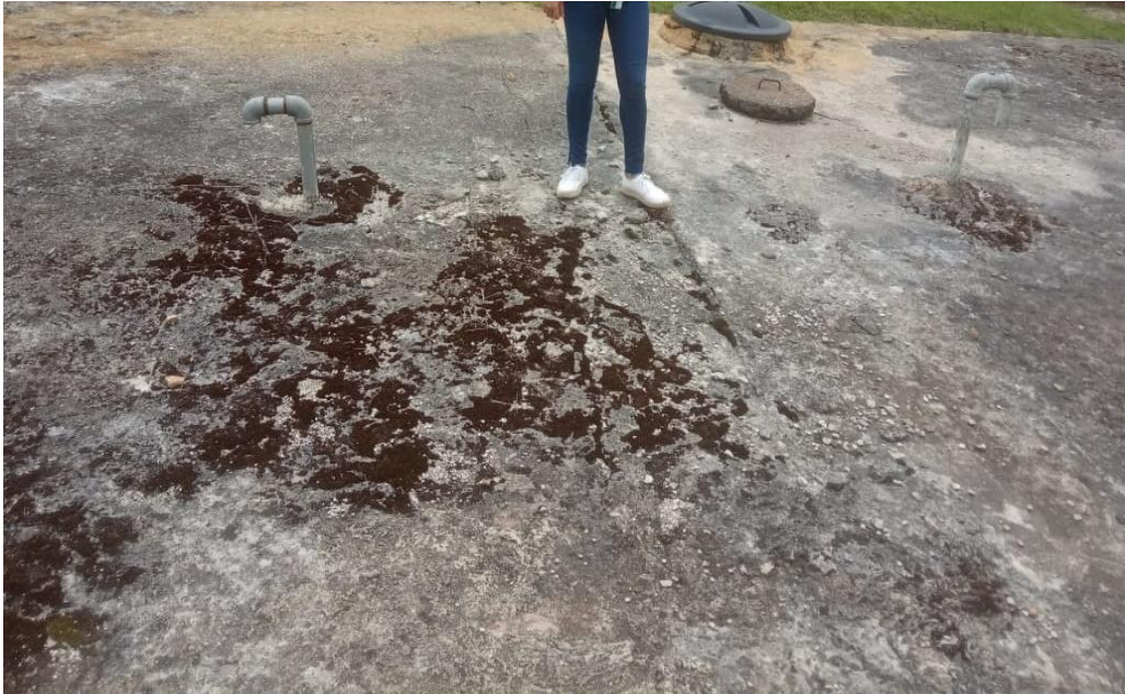
Ilustración 9: Tanques de almacenamiento.
