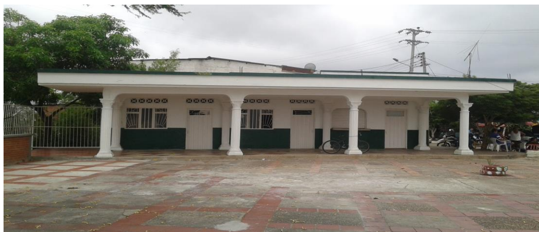
Imagen 6. Edificio en el que funciono alguna vez un punto refrescante. Hoy sin uso
