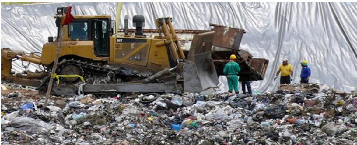
Figura 9. Relleno sanitario Parque ecológico, Praderas del Magdalena
