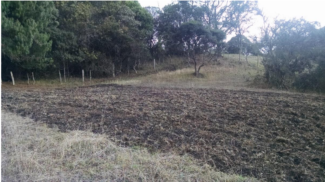
Fotografía 5. Preparación del terreno
