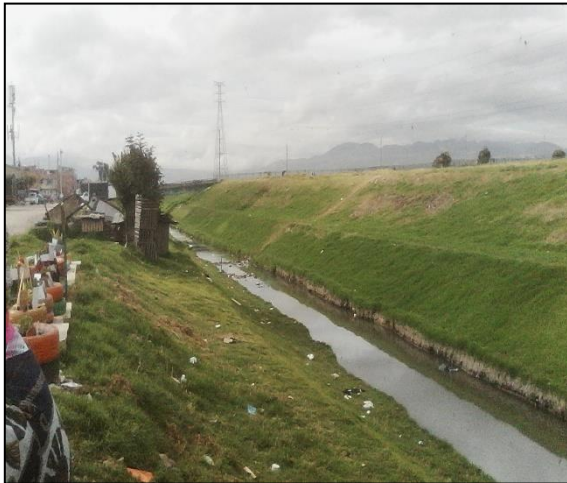
Figura 1. Contaminación por disposición inadecuada de residuos en el canal Tintal II – Barrio Jazmín Occidental (Localidad de Bosa). Fuente: Autor
