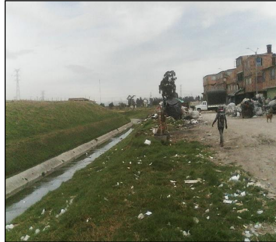
Figura 2. Contaminación por disposición inadecuada de residuos en el canal Tintal II – Barrio Jazmín Occidental (Localidad de Bosa). Establecimientos de recicladores de oficio que disponen residuos al canal (Fondo de la imagen). Fuente: Autor
