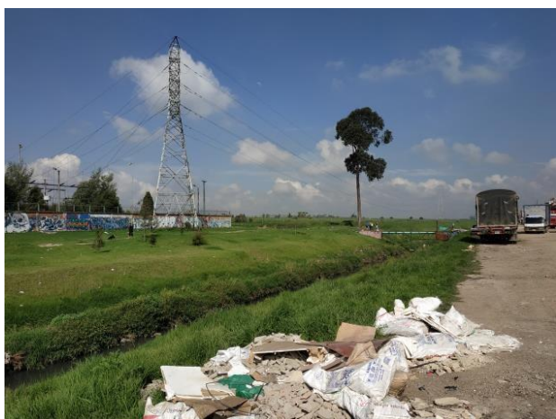
Figura 35. Disposición inadecuada de residuos en el canal Tintal II – Barrio Sumapaz (Localidad de Bosa). Fuente: Autor
