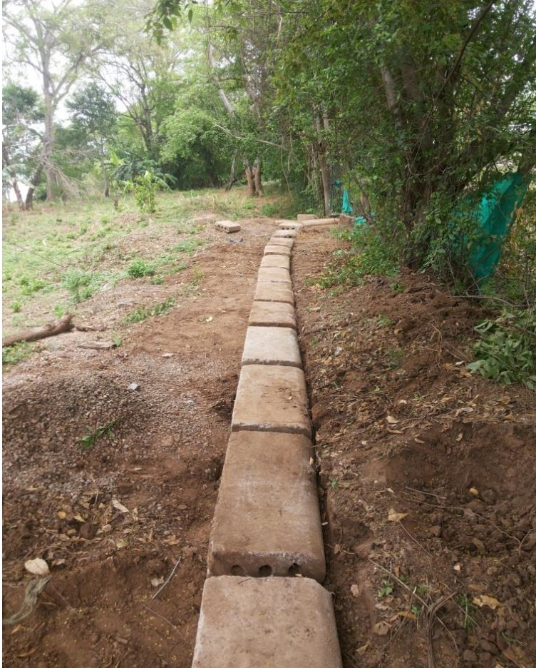
Imagen 10. Sendero peatonal de la PTAR
