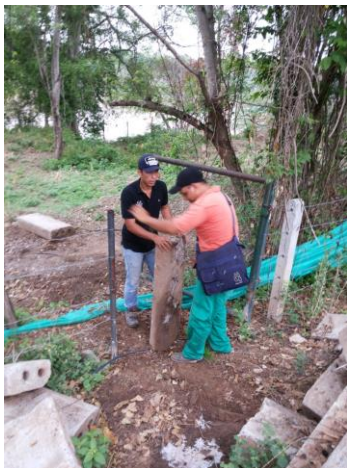
Imagen 8. Preparación del terreno
