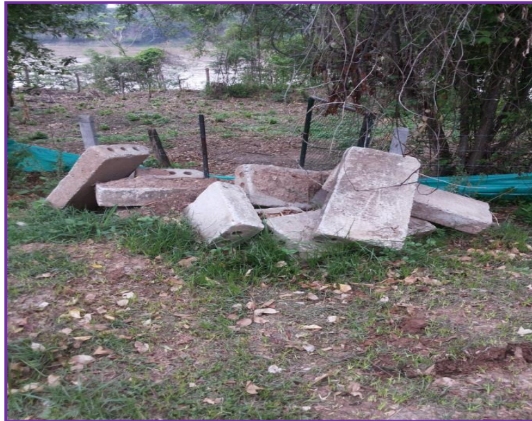
Imagen 7. Material para la construcción del sendero peatonal
