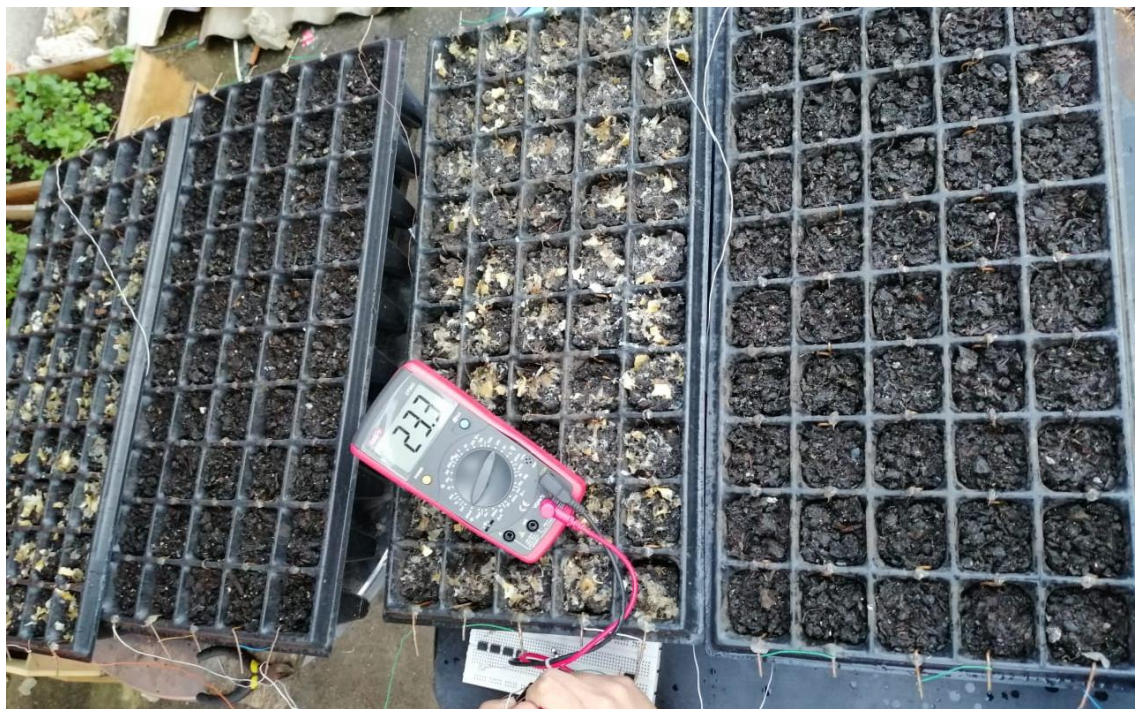
Imagen 55 Medición de voltaje suministrado por las 4 bandejas conectadas en paralelo sin carga
