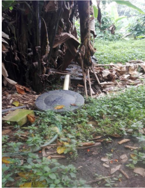
Figura 35 Tanque recolección de aguas residuales. Se observa el tanque de recolección donde se da un tiempo de fermentación y luego es vertido a cultivos.
