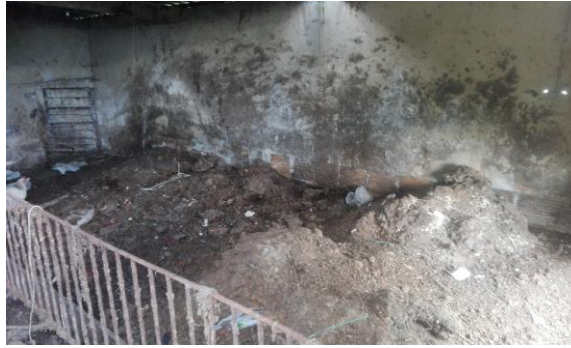
Figura 31 Almacenamiento de residuos dentro de instalaciones de alojamiento de cerdos.
