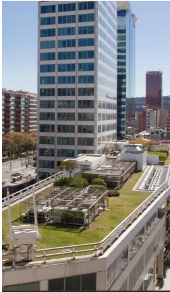
Figura 6: Techo verde intensivo (Fuente: 22)
