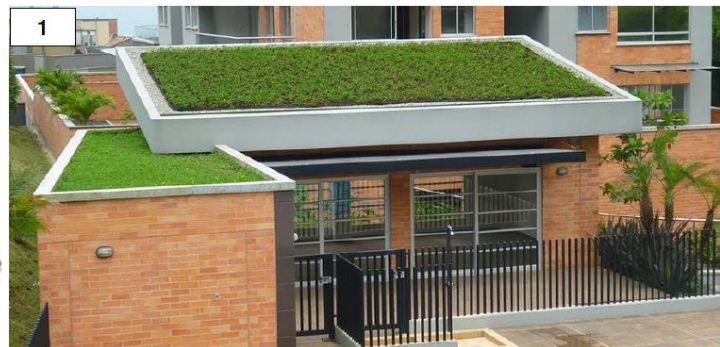
Figura 2: Techo verde extensivo (Fuente: 11)
