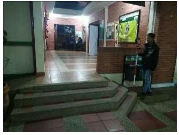
Ilustración 4 Identificación Detalles-2- Fuente propia
