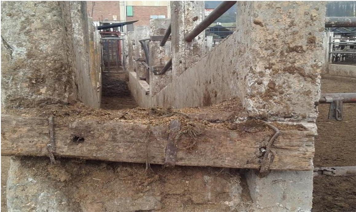
Figura 10. Desembarcaderos deteriorados
