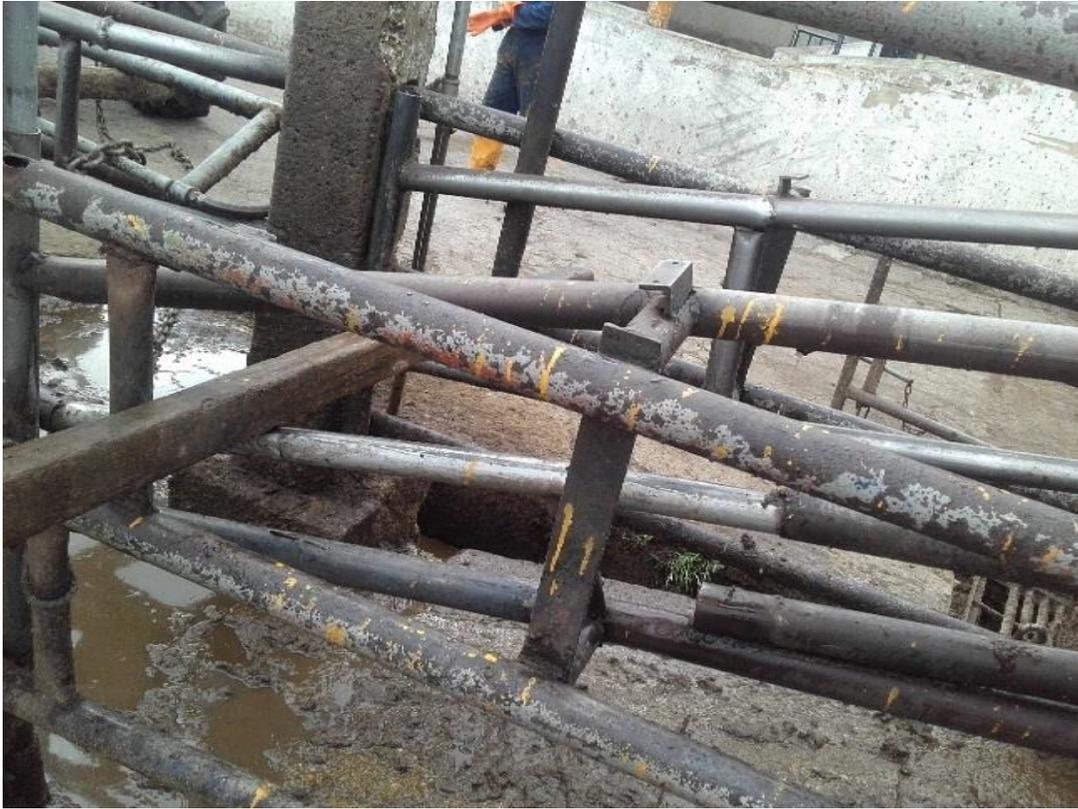
Figura 19. Tubos en deterioro (elementos corto punzantes)
