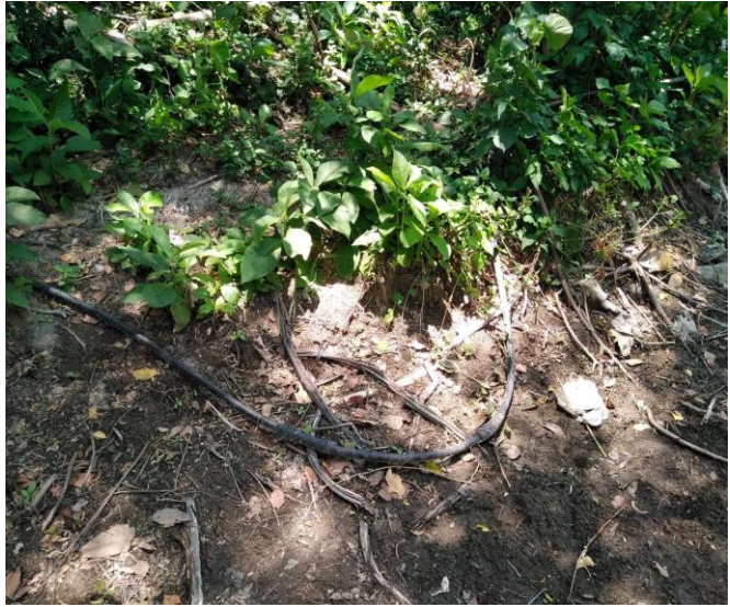
Ilustración 5. Captación de agua – Mangueras Autor: Fuente propia
