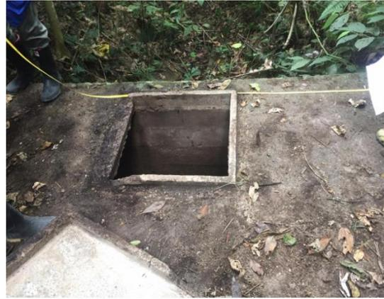
*Ilustración 18 Tanque desarenador
