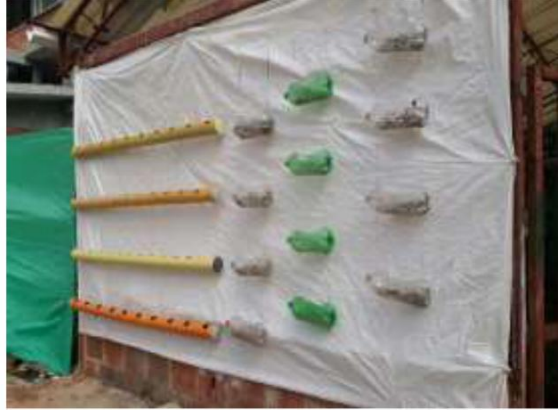
Figura 2. Montaje del sistema vertical
