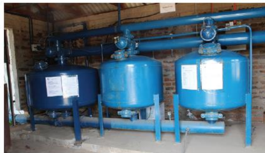
Figura 44. Filtro de arena de cuarzo (estanque). (Martínez et al., 2014).
