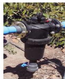
Figura 48. Filtro de autolavado (Martínez et al., 2014).
