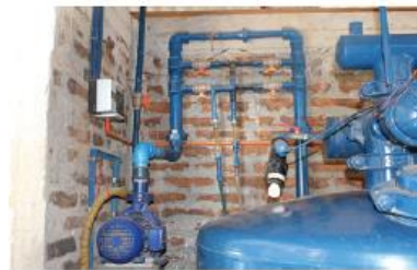
Figura 50. Bomba inyectora de fertilizante (Martínez et al., 2014).
