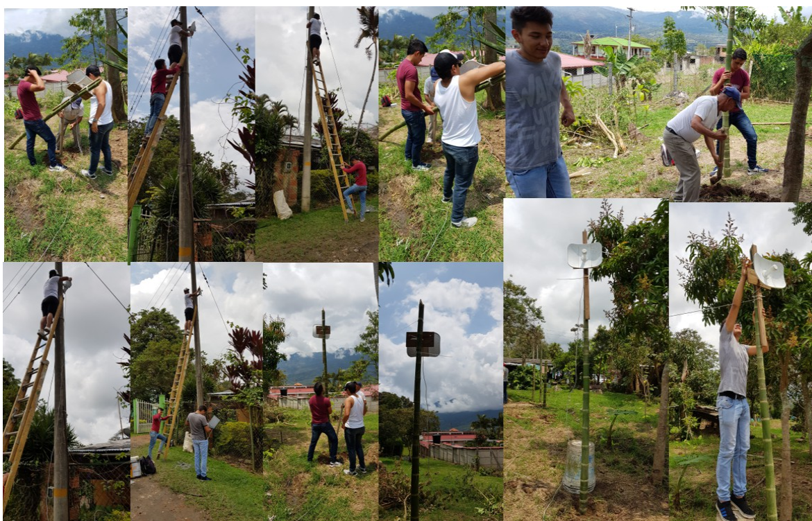
Figura N° 14: Pruebas de instalación comunidad Familia Martínez (Autor).
