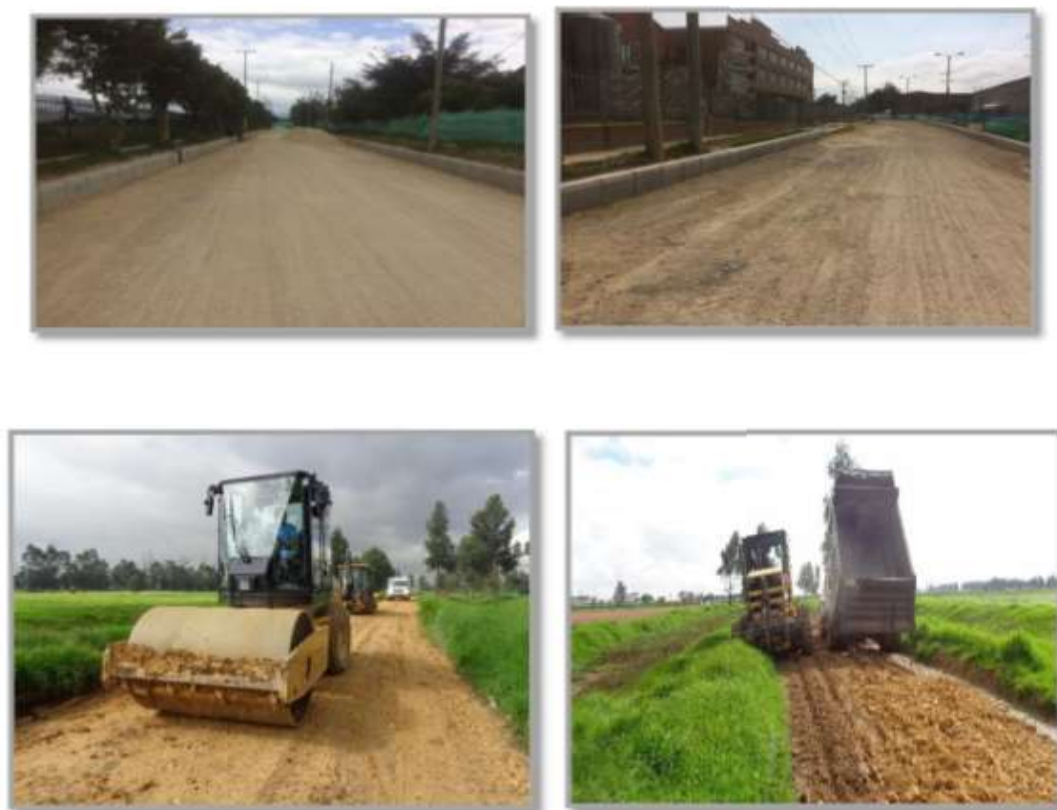
Figura 18: Evidencia del mantenimiento de vías rurales año 2017
