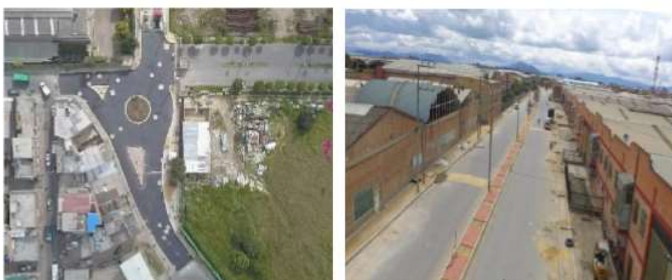
VIA Y GLORIETA MONTANA
