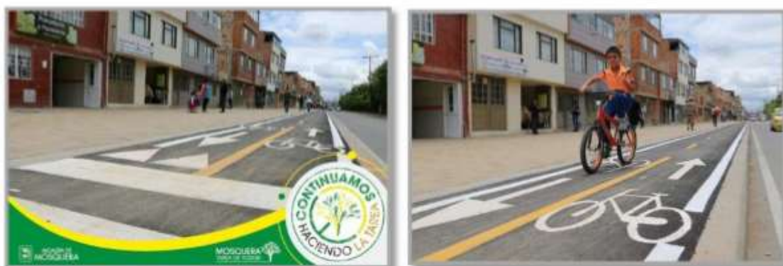
Figura 16: Evidencia del mantenimiento de ciclo ruta urbana año 2017
