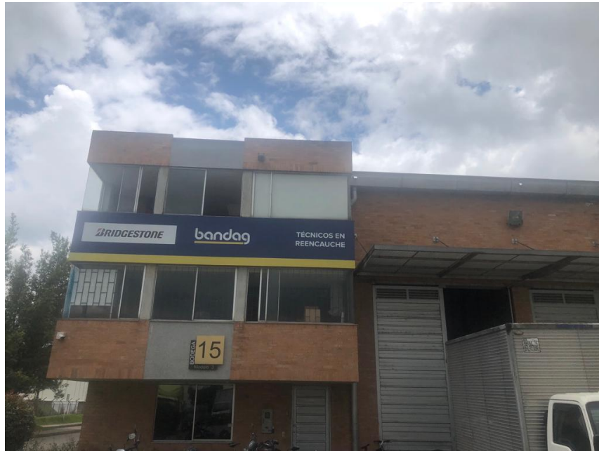
Fuente: Técnicos en Reencauche SAS 1.Instalaciones de la Empresa
