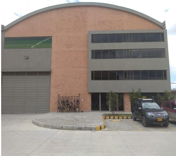
Figura 2 Instalaciones Drycol SAS, Mosquera
