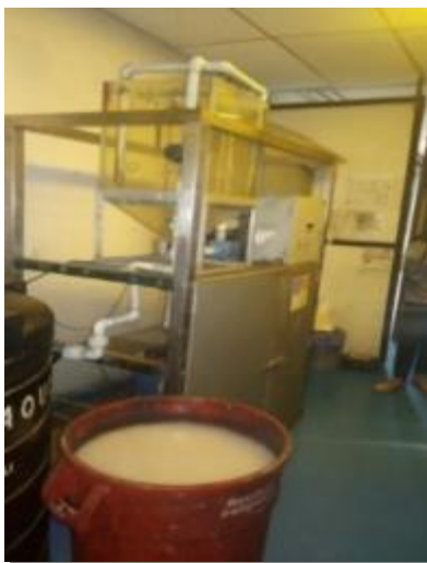
Figura 37. Planta de tratamiento de aguas residuales – PTAR generadas en el área de remasterizado. Fuente: elaboración propia.
