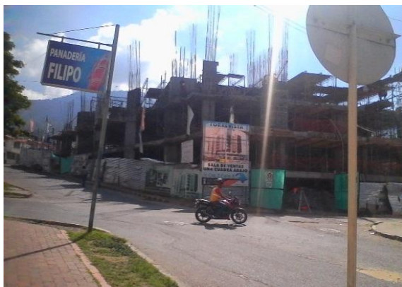
Proyecto torre de apartamentos Torrevista Esquina carrera 1 con av. Las Palmas Fuente: propia
