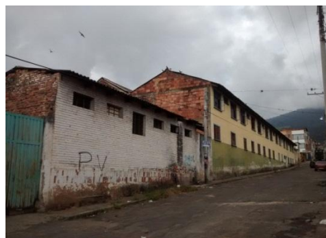
Antiguo Ancianato municipal Vista calle 3 Fuente: propia
