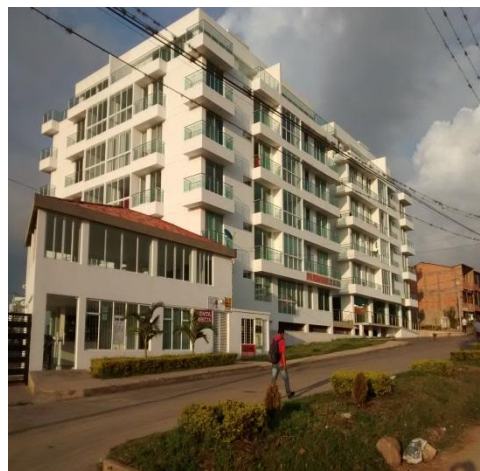
Torre de apart Parques los Cambulos Fuente: propia
