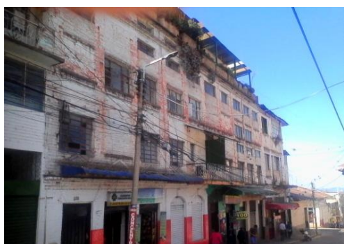
Casa calle caliente. Vista calle 4 entre carrera 5 y 6
