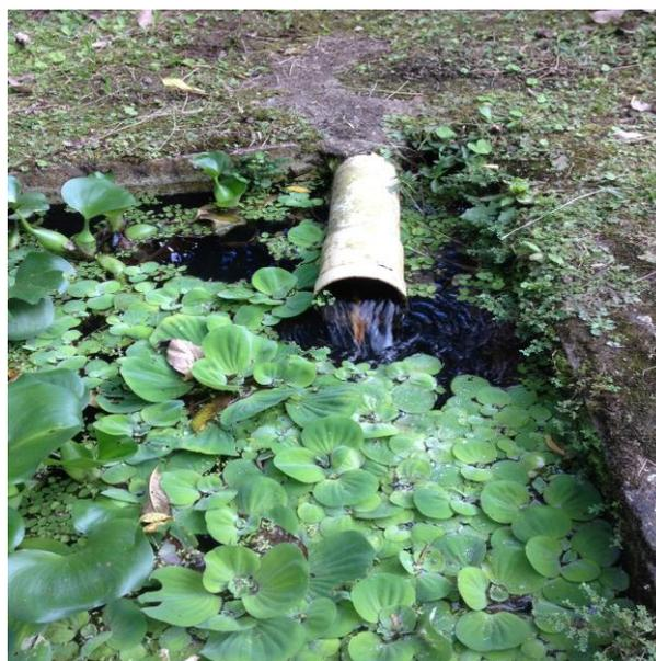
**Ilustración 36 Captación con tubo PVC.**
