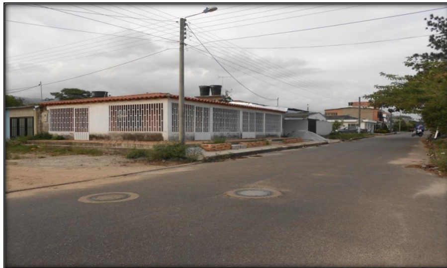
Fotografía21 Barrio Villa del Prado
