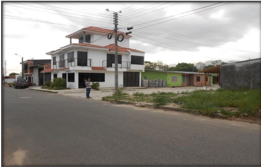
Fotografía23 Barrio Villa del Prado
