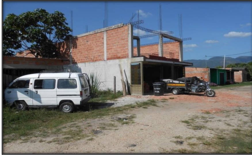
Fotografía34 Barrio la Pradera
