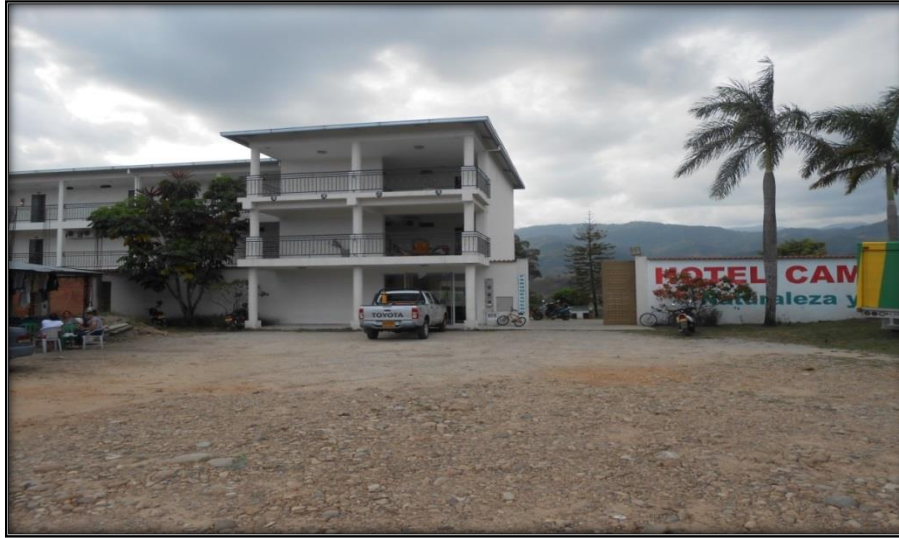
Fotografía20 Barrio Villa del Prado
