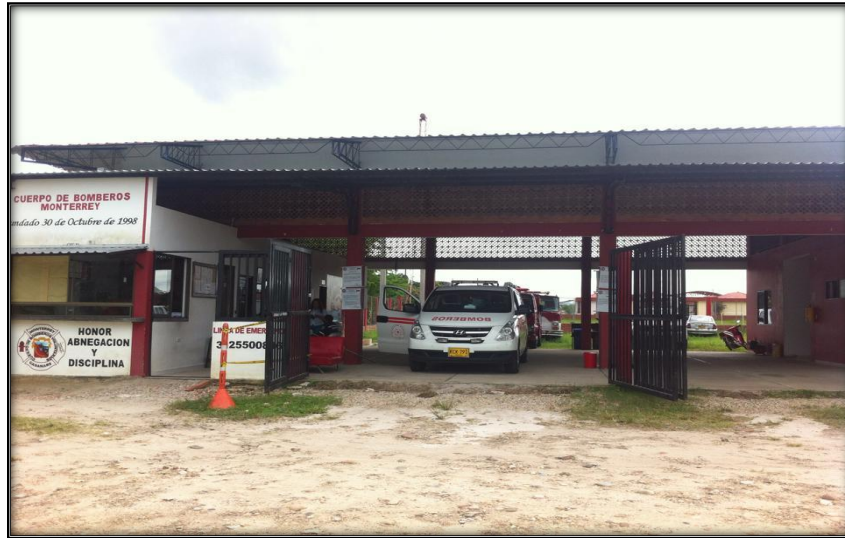
Fotografía12 Estación de Bomberos
