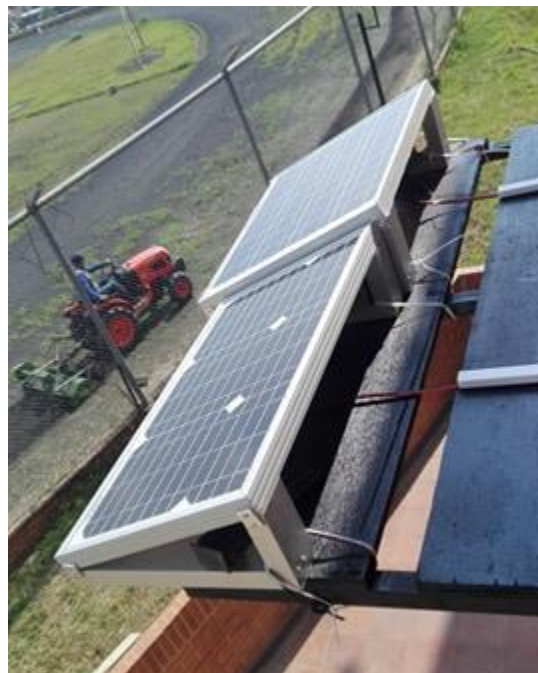
Figura 19 Instalación paneles fotovoltaicos monocristalino y policristalino Fuente: Propia
