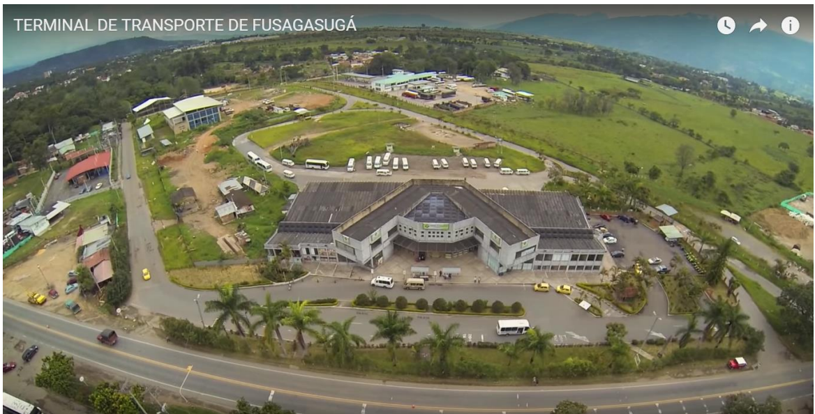
Fuente Archivo Terminal de Transportes
