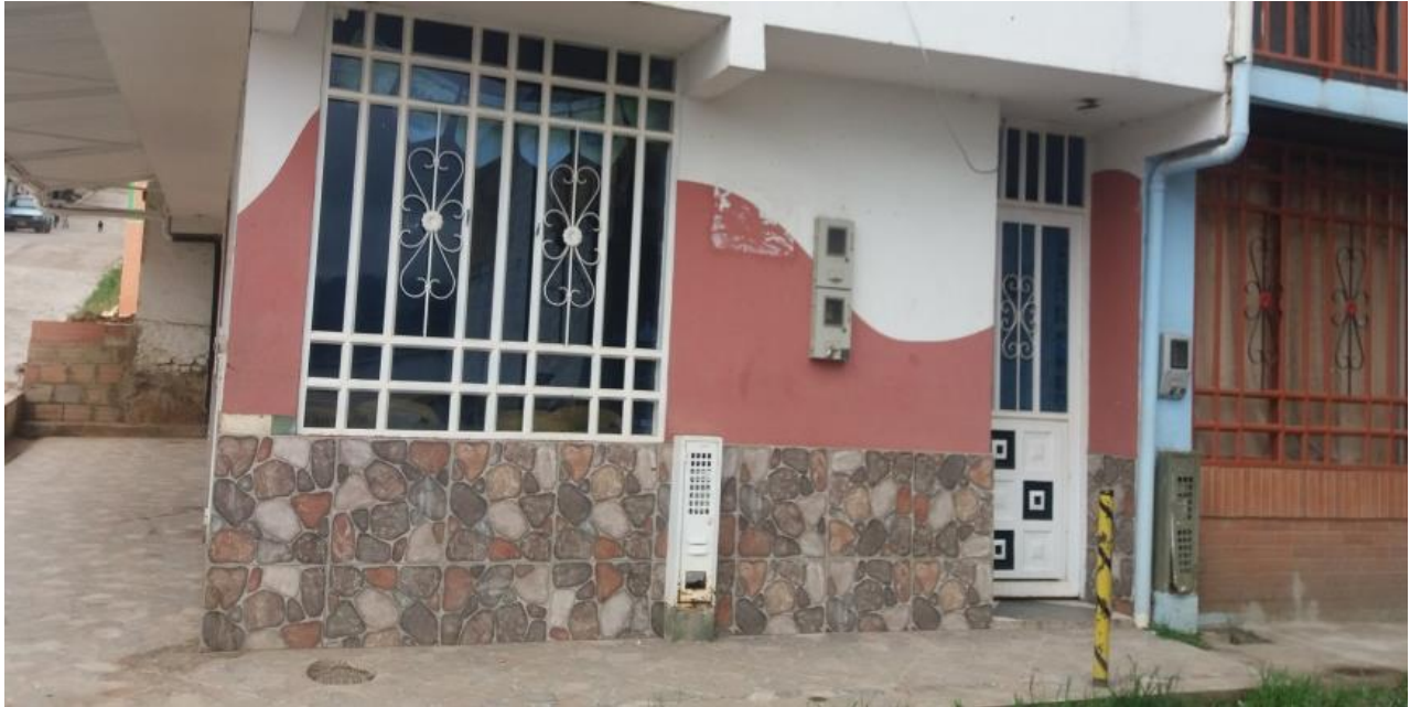
IMAGEN 10 Una de las 285 Fachadas Del Zona de Estudio Fuente: Propia
