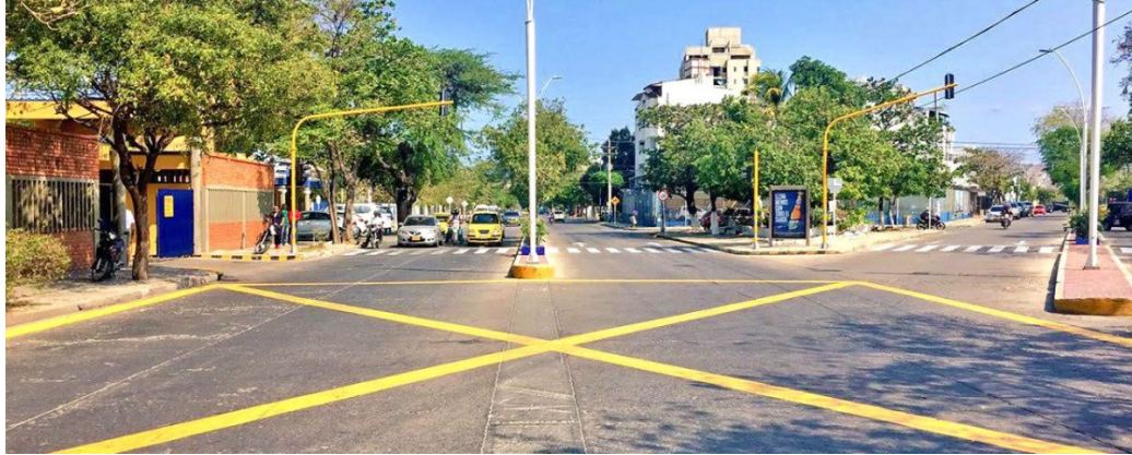
Ilustración 9. Intersección Semaforizada en la Av. de los Estudiantes – Conexión a la entrada de dos vías centrales de la ciudad de Santa Marta
