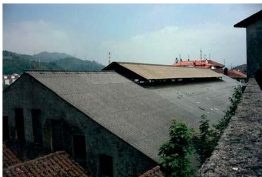
Figura A1.18 Placas onduladas y planas (cubiertas)
