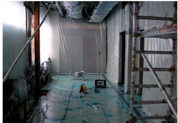
Figura A3.25 Muestreo de aire en el interior de la burbuja después de la limpieza y aplicación del fijador
