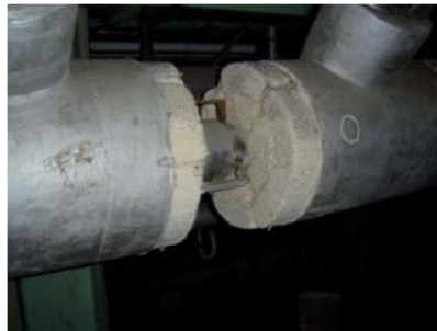
Figura A1.30 Detalle de calorifugado (coquilla)
