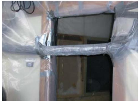
Figura A3.5 Protección de elementos
