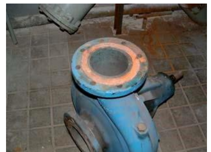
Figura A1.34 Junta de presión en una bomba centrífuga
