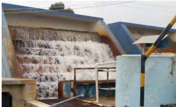
Figura 3. Torres de aireación de la PTAP de la E.A.F. S.A.S. E.S.P
