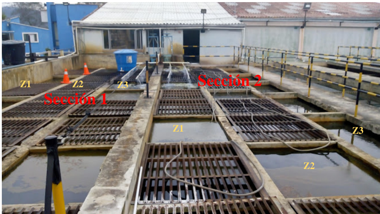
Figura 6. Secciones y zonas paralelas de los floculadores
