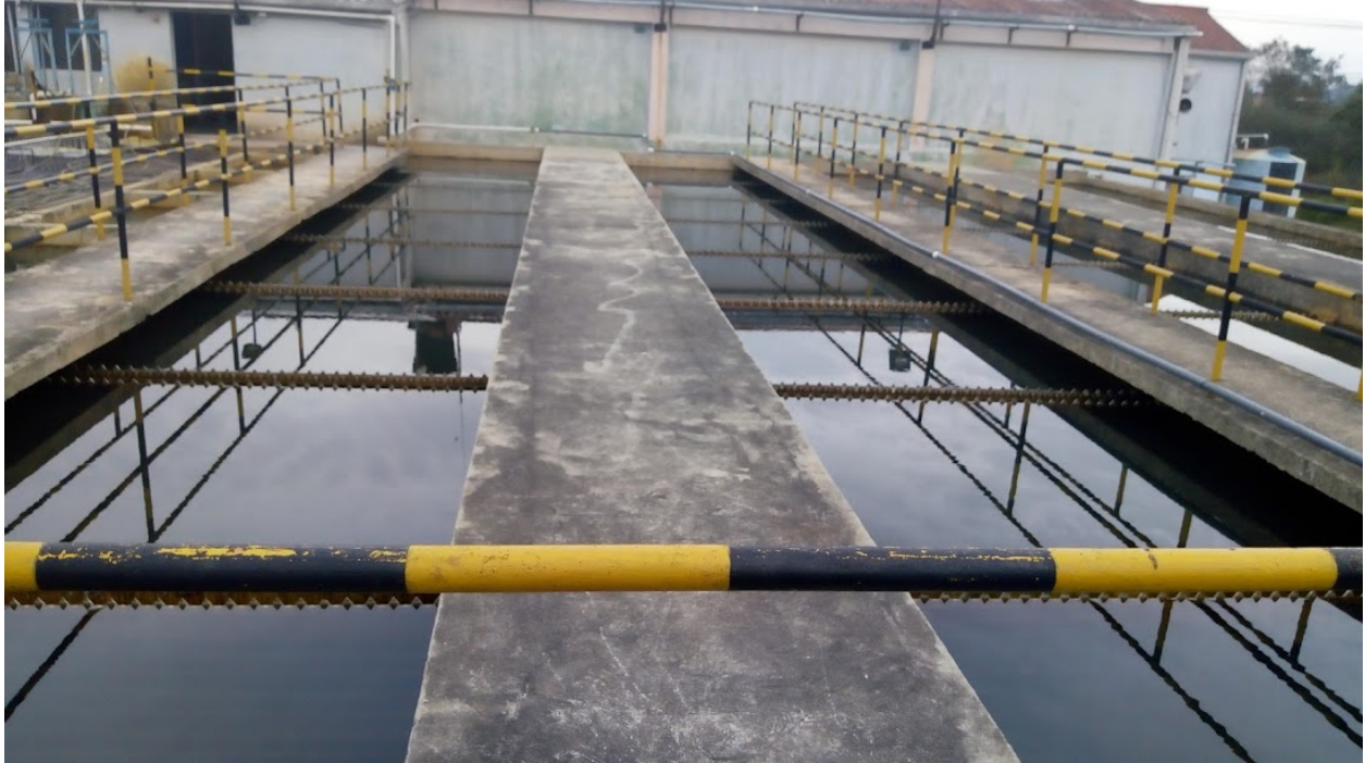
Figura 8. Sedimentadores de alta rata de la planta de la E.A.F. S.A.S. E.S.P.
