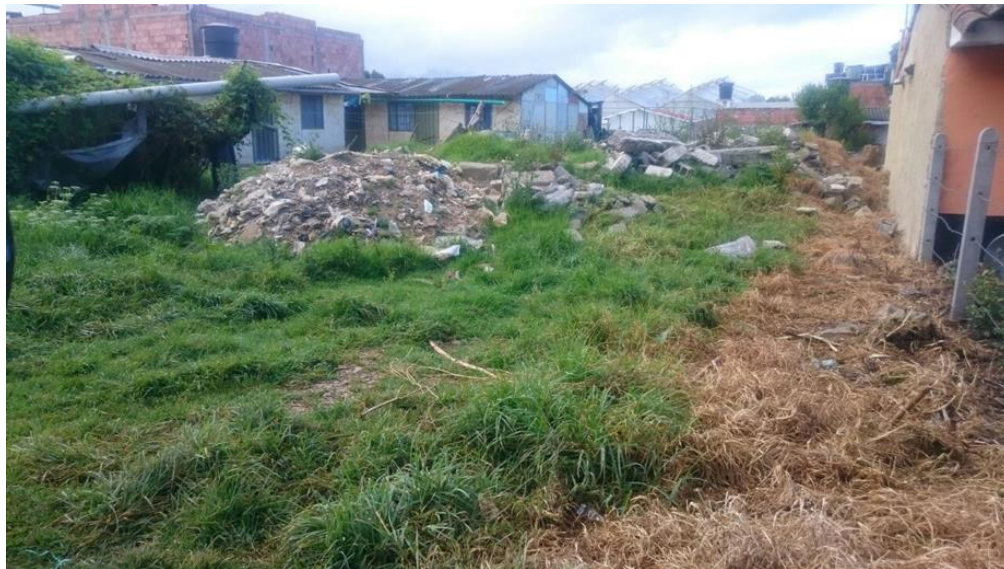
Fotografía 3 Residuos de construcción y demolición
