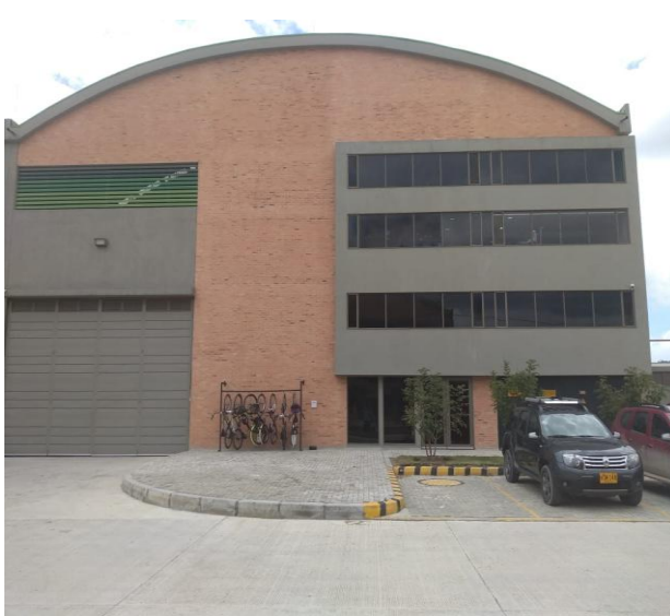
Figura 2 Instalaciones Drycol SAS, Mosquera
