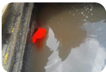
prueba con anilina identificacion de conexion errada
