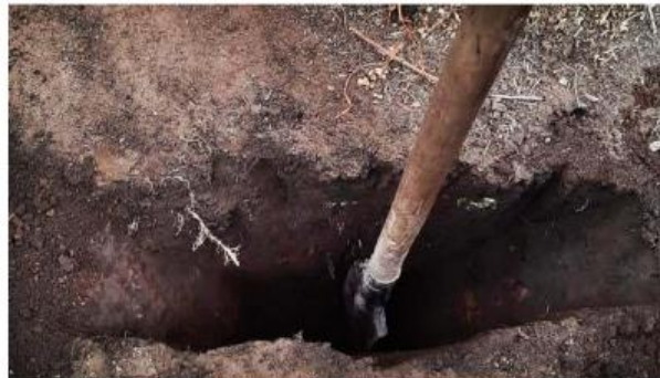
Figura 4.14: Hoyo en forma de “V” con 60cm de profundidad.
