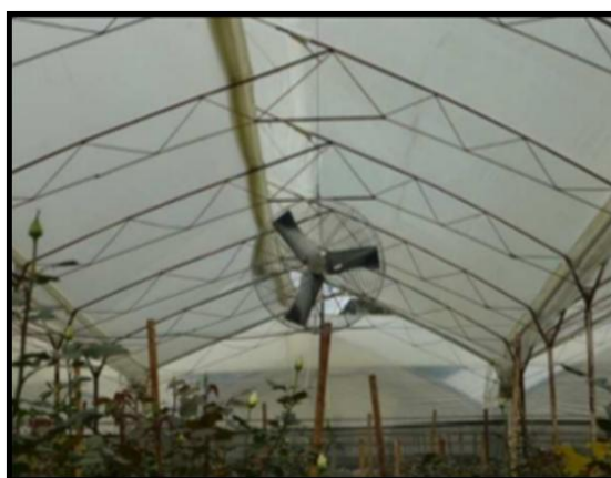
Ilustración 18. Instalación de ventiladores bajo invernadero de Rosa spp. Fuente: instructivo para manejo integrado de Mildeo polvoso.
