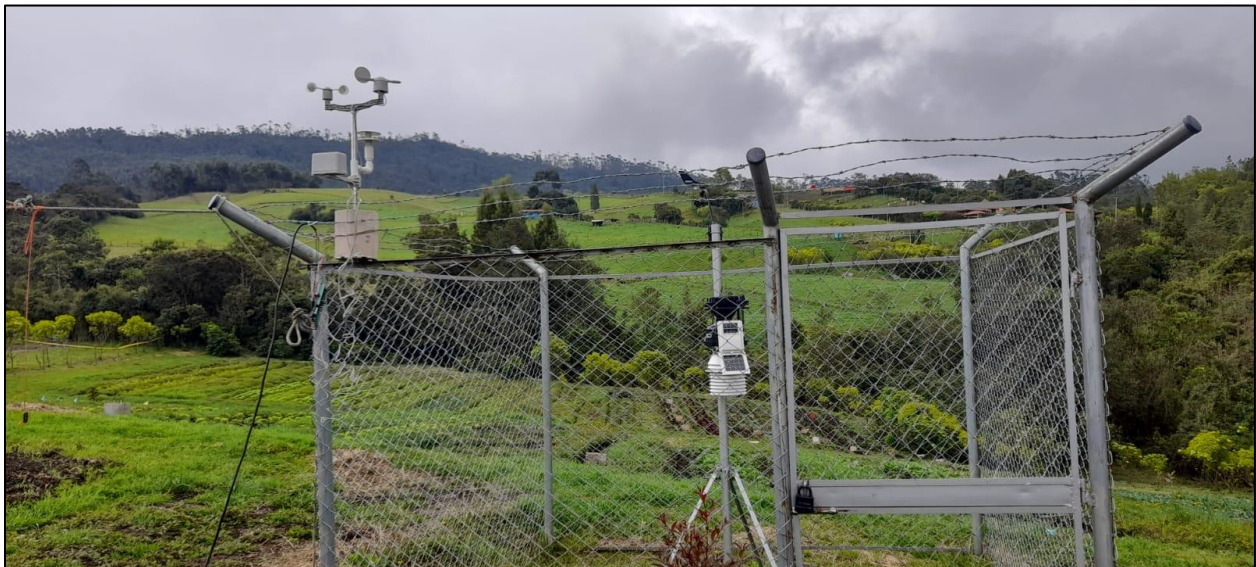
Instalación de estación meteorológica (FOTO AUTOR)
