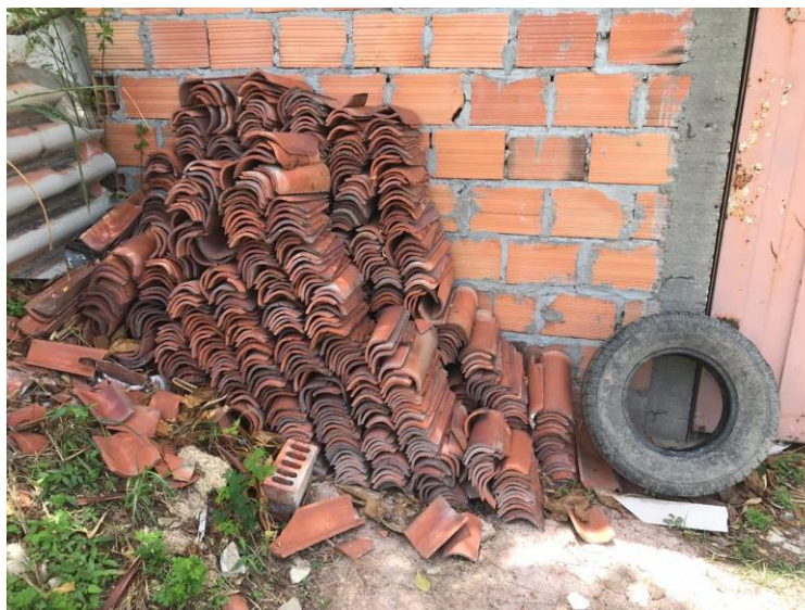
Ilustración 33. Disposición inadecuada de residuos
