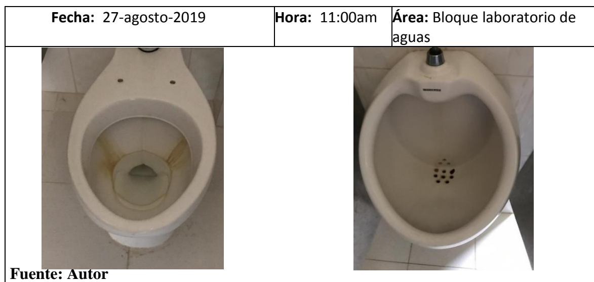
Ilustración 7: Baños bloque de aguas
