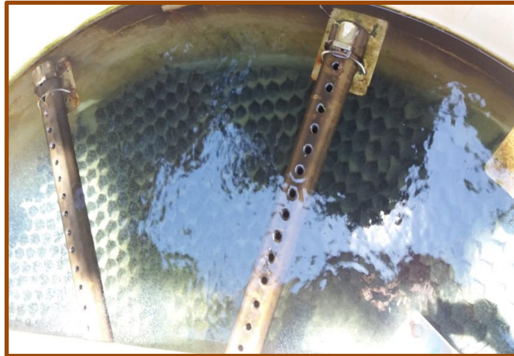
Imagen 8. Sedimentador. Fuente: Autor (Septiembre, 2016)
